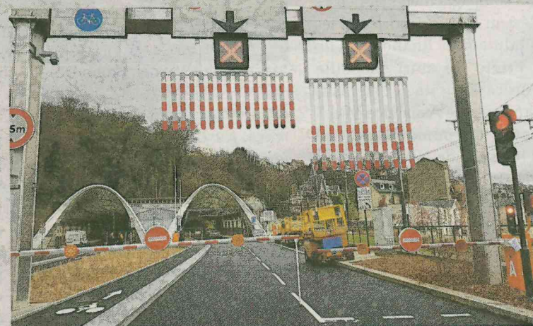
Des barrières baissées à l'entrée du tunnel : un constat trop fréquent
