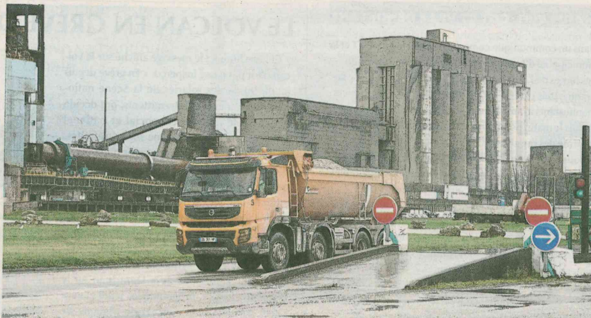
En 2016, Lafarge annonçait transformer sa cimenterie en usine de broyage. Sur 144 postes, 39 subsisteront. (Archives PN)
